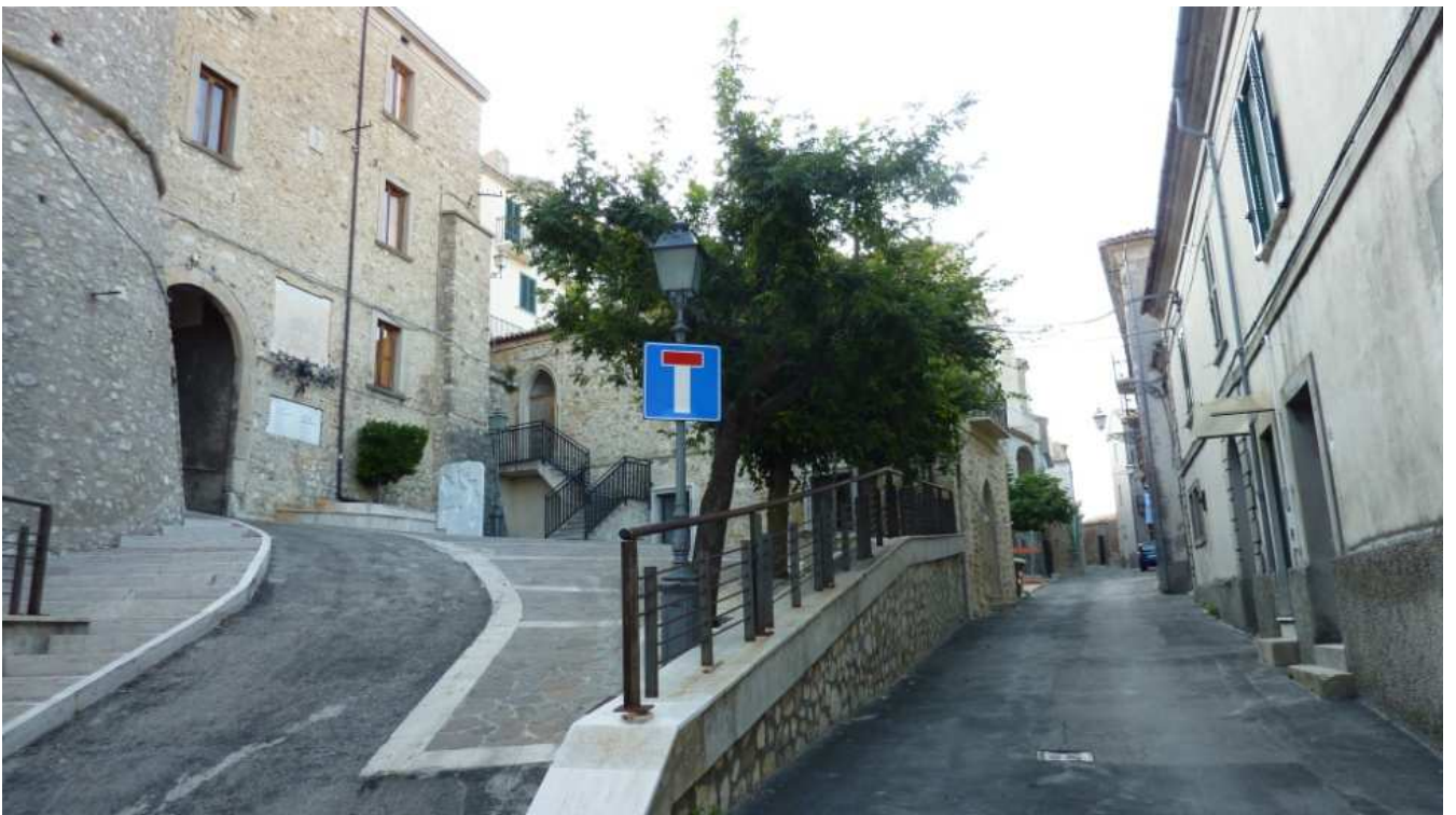
Altra vista del Torrione d'ingresso
